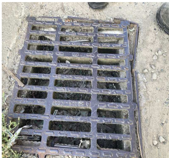
Grille équipée d'un filtre anti-pollution
