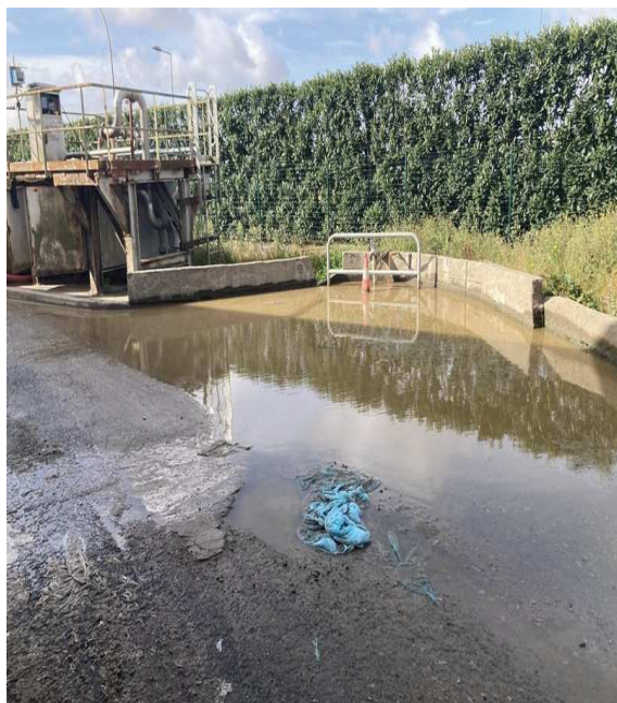
Évacuation bouchée entraînant une mare d'eau – des fils électriques baignent dans l'eau
